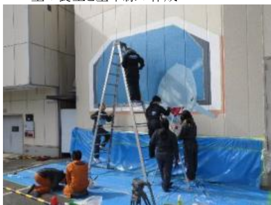
高所作業には脚立を用いた
