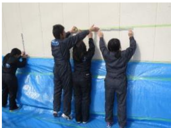
壁の養生と基準線の作成
